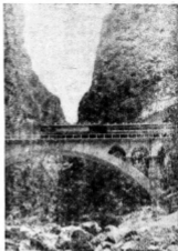
上是青天一线，下是峡谷深涧的一线天桥。
