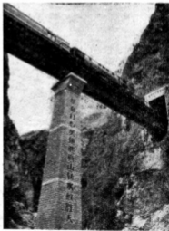
桥入隧道、隧中有桥。象这样的工程，成昆路上还有多处。
