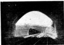
湘黔铁路有不少车站线路铺设在多线桥上或多线隧道里。
