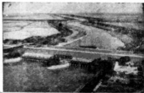
河北省黑龙港地区南排河上的倒虹吸工程。
